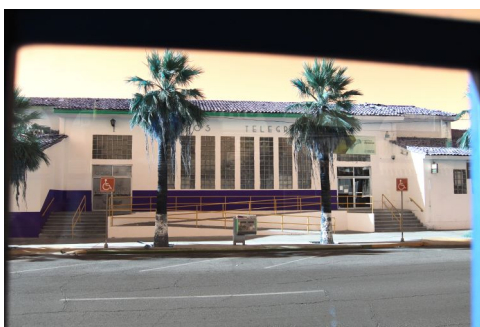
FIGURA 9. Edificio de Correos de México
