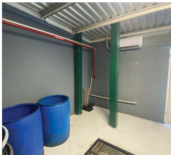
Figura 4. Cuarto frío donde se guardaron los residuos orgánicos generados.
