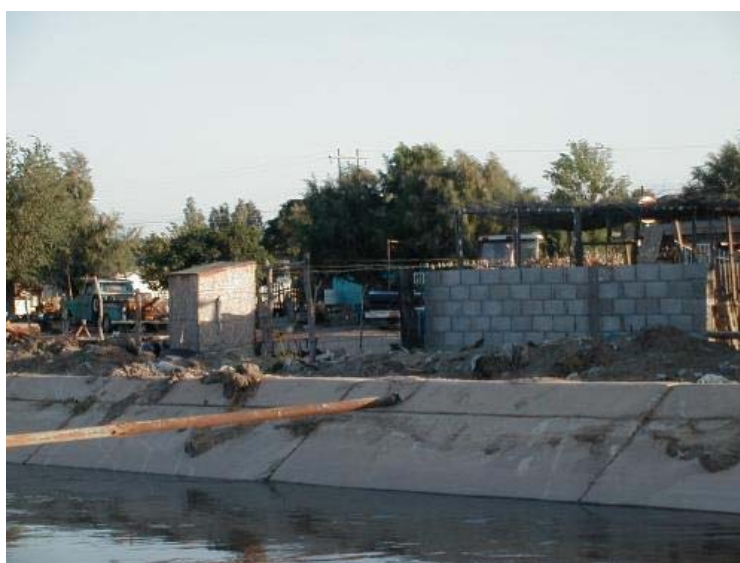
Figura 2. Canal abierto con aguas mezcladas y lodos de desazolve
