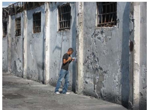
Figura 10 Uso del esclerómetro para obtener el esfuerzo f'_c de las columnas y de la dala de cerramiento
