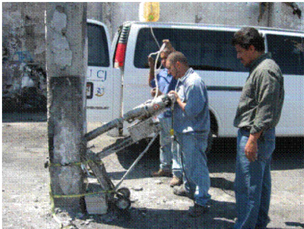
Figura 8 Proceso de extracción de núcleos (corazones) de las
