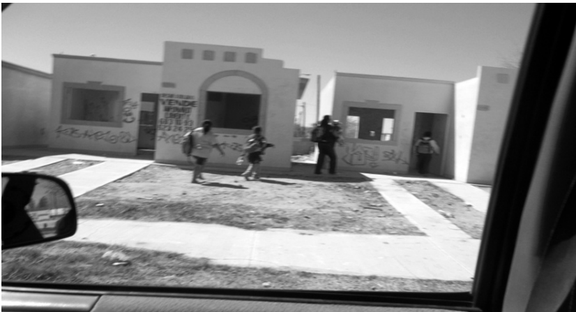
Foto 5. El uso cotidiano de las casas abandonadas como “vía corta”
