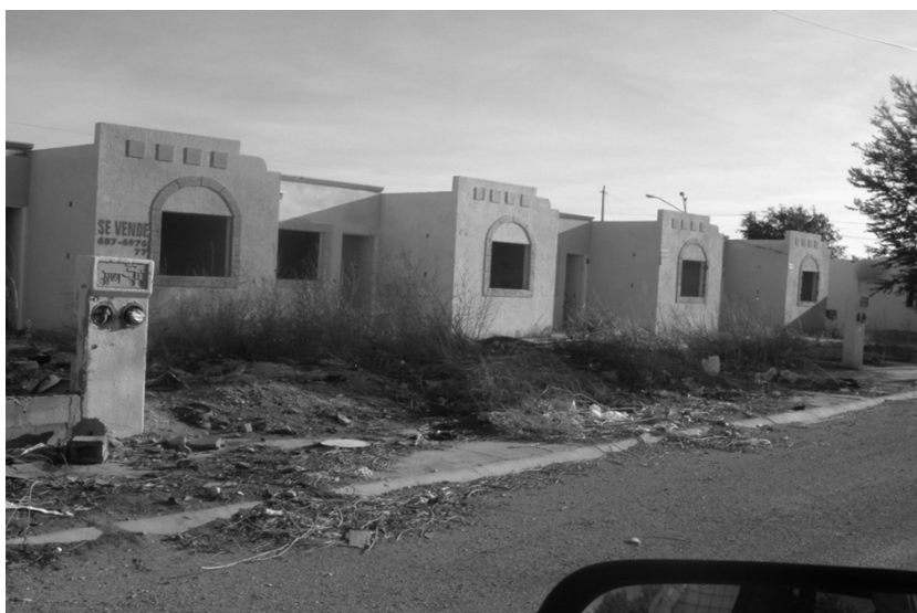
Foto 4. Casas abandonadas y vandalizadas en Riberas del Bravo
